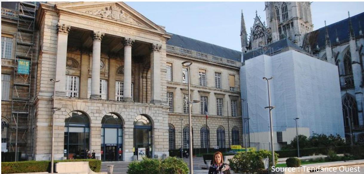
Pour atteindre un très haut niveau de performance énergétique (équivalent au BBC Rénovation) sans modifier la façade, les actions suivantes ont été entreprises : isolation de la toiture et des combles, remplacement des verrières de la toiture et des menuiseries bois simple vitrage. Par ailleurs, il a été nécessaire de mettre en place un système de chauffage innovant et d'intégrer les utilisateurs à leur gestion.
