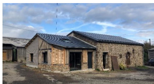
Local d'accueil financé grâce à l'aide à la transformation à la ferme (M421)
