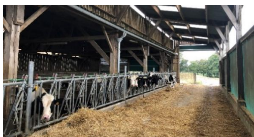
Bâtiment d'élevage et équipements (cornadis) financés grâce à l'ANP (M411)
